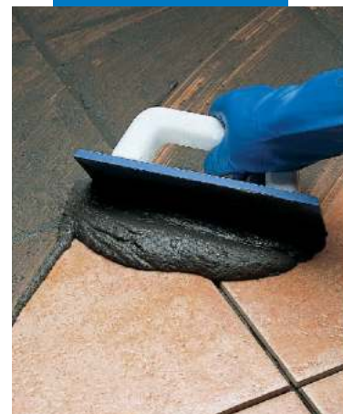
Relleno de boquillas de monococción, con lana
