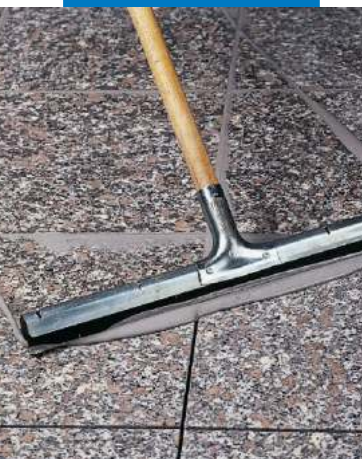
Emboquillado en pisos de granito prepulido, con jalador
