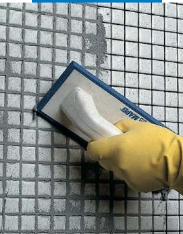
Emboquillado de junta de revestimientos de mosaico vítreo (en baño) con llana
