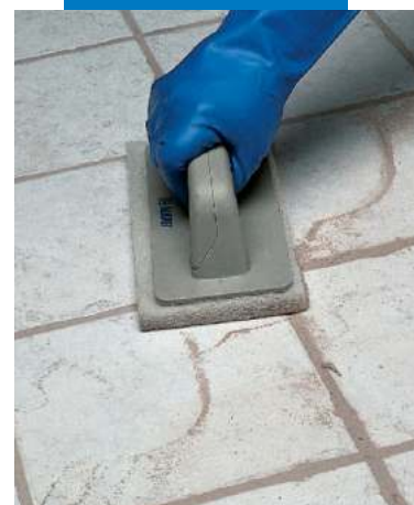
Terminación con Scotch-Brite®
