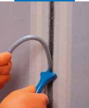
Insertar Mapefoam en el interior de la sede de la junta
