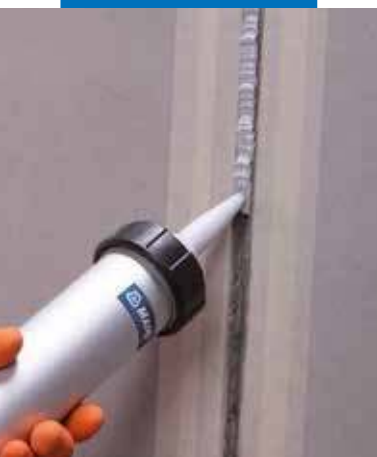
Aplicación de Mapeflex PU40
